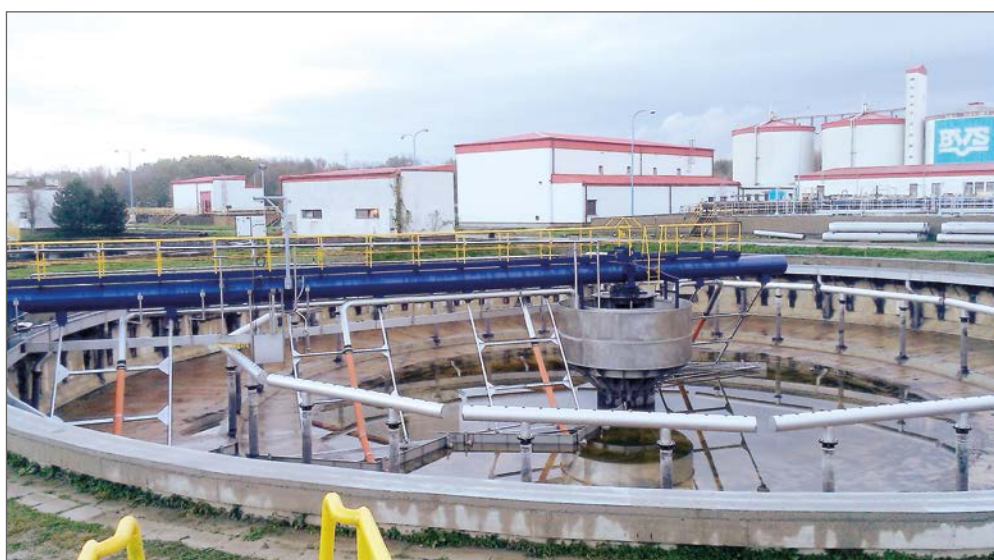
Dosazovací nádrže slouží k zajištění sedimentace kalu, jeho transportu, odstranění plovoucích nečistot z hladiny a odvodu vyčištěné vody
